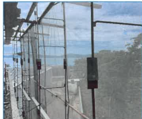
ภาพถ่ายที่ 2.1-4 รั้วทึบกันรอบพื้นที่โครงการพร้อมตาข่ายกันรอบอาคาร
