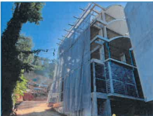
ภาพถ่ายที่ 2.1-4 รั้วทึบกันรอบพื้นที่โครงการพร้อมตาข่ายกันรอบอาคาร
