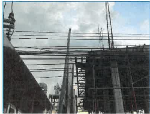
ภาพถ่ายที่ 2.1-4 รั้วที่บั่นรอบพื้นที่โครงการพร้อมตาข่ายกันรอบอาคาร
