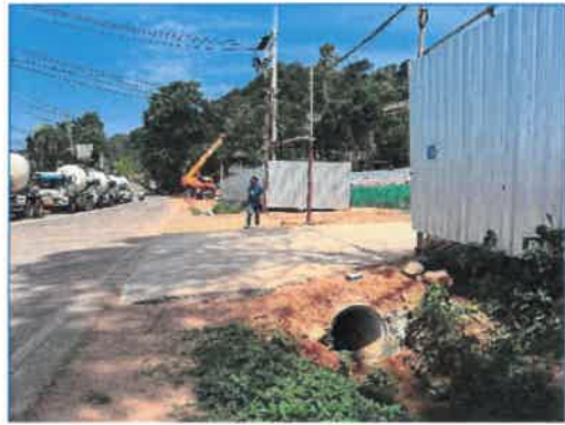
ภาพถ่ายที่ 2.1-3 การจัดทำท่อระบายน้ำด้านหน้าโครงการ
