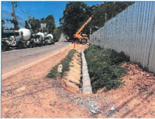
ภาพถ่ายที่ 2.1-3 การจัดทำท่อระบายน้ำด้านหน้าโครงการ
