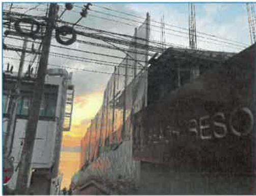
ภาพถ่ายที่ 2.1-4 รั้วที่บั่นรอบพื้นที่โครงการพร้อมตาข่ายกันรอบอาคาร
